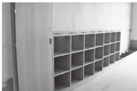
ロッカー設置工事中の教室
