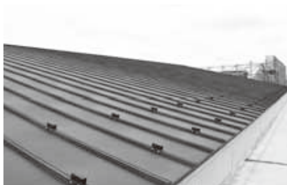
施工が完了した校舎西側の屋根
