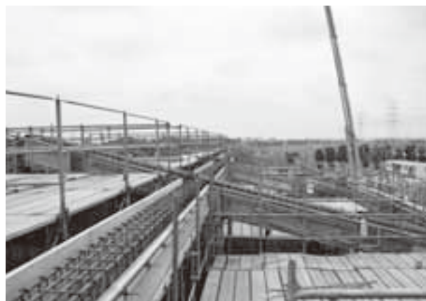
型枠が設置された校舎の屋根
