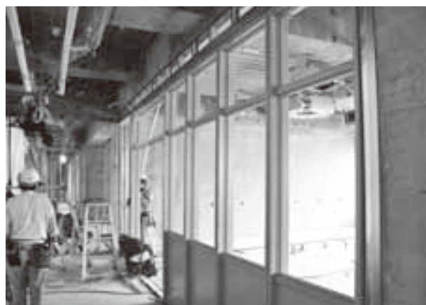
パーテーションが設置された教室(廊下側)
