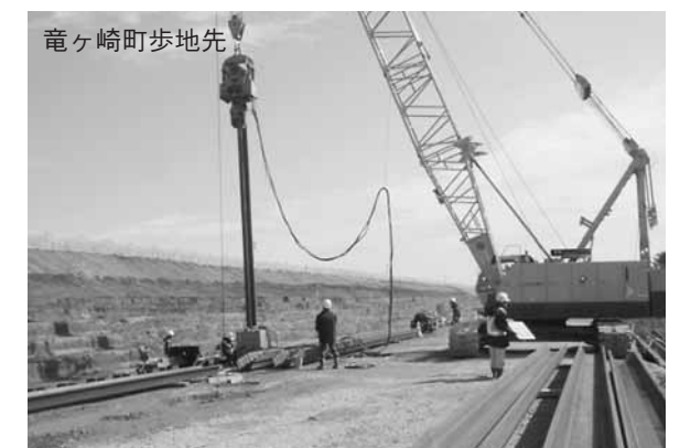
竜ヶ崎町歩地先 本格的な復旧工事（H24）
