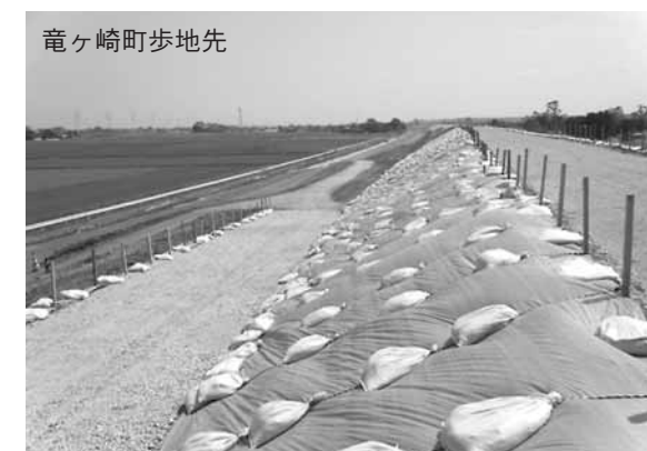
竜ヶ崎町歩地先 応急復旧（震災直後H23）
