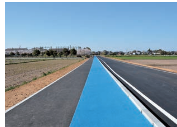
▲新設された歩道 (青色は自転車通行部)
