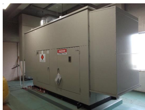
【非常用発電機】
