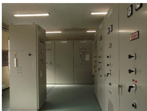
【制御設備・計装設備】
