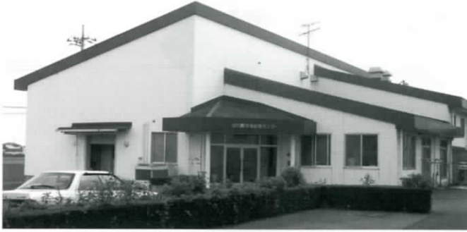
河内町給食センター
