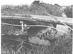
完成した橋(右)と古い橋(左)
