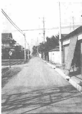
57年度に完成した田川地区の道路
