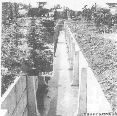
整備された保村の集落排水
