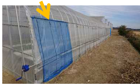
図- 30 防風ネットによる被覆資材の破損防止
