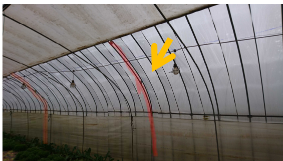
図-3-3 ダブルアーチパイプによる強化
