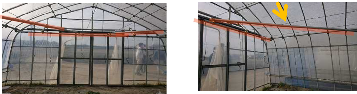
図- 28 足場用直管パイプによる妻面補強
