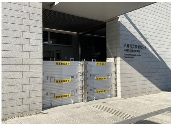
■八潮市：出入口の防水板と堅牢な外壁
