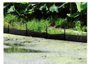
図2 波板により畦畔補強した例
