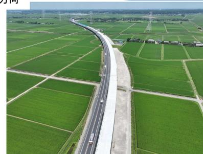
上記は、上空からの写真となります。写真の白い箇所は、上部工工事が完了し、舗装・施設工事への引渡しが完了しております。
